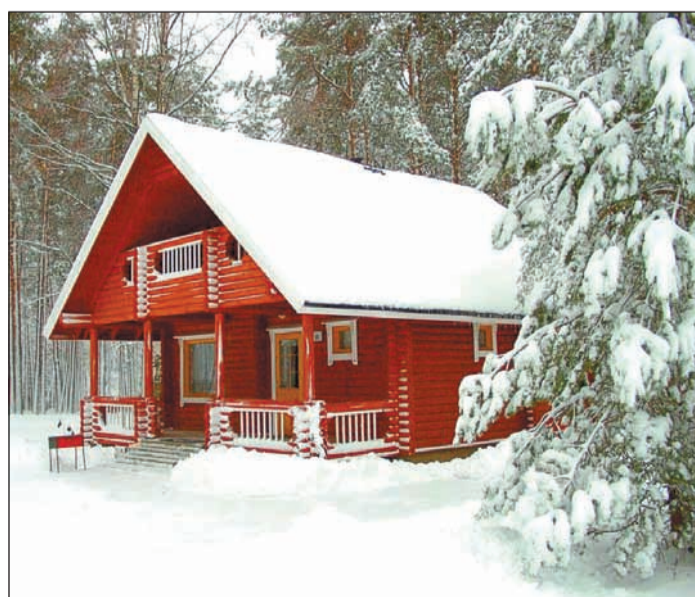
• Монтаж всех внутренних систем специалисты фирмы выполняют на высоком качественном уровне. Фото www.greenvillage.ru.
